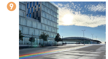
GARE MONTPELLIER SUD DE FRANCE 850 000 passagers/an
