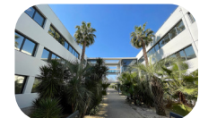
1 380 m 2 WEDA - Espace Concorde - Parc de l'Aéroport Pérols
