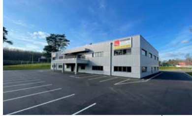
- ST-ETIENNE DU ROUVRAY - Location 1 500 m 2
