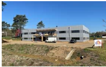
- ST-ETIENNE DU ROUVRAY - Location 1 500 m 2
